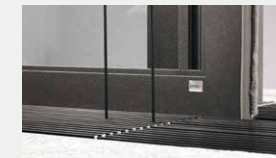
Verdeckte Seilabspannung bei neuem Entwässerungsschacht
