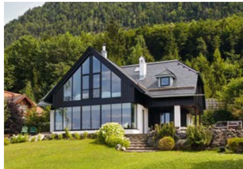
Das Holz/Alu-Ganzglas-System Platin Blue an der seeseitigen Fassade reicht vom Boden bis zum Giebel über zwei Wohnebenen hinweg und öffnet das Haus auf luftige Weise komplett zum Wasser hin.
